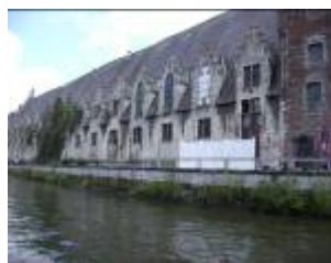
(vue arrière du bâtiment)
